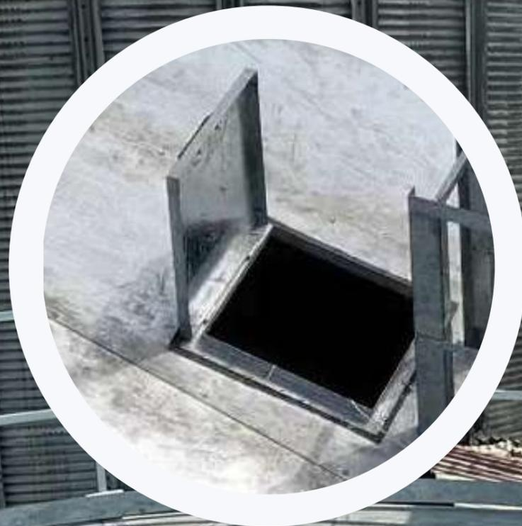
Nuestros depósitos cuentan con manhole de techo para el ingreso al depósito por la parte superior, la tornillería, la tapa y el refuerzo son diseñados para resistir el peso de los operarios y equipos en el techo.
