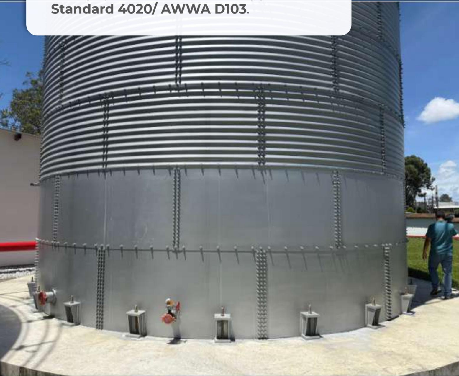
Anclaje por volcamiento embebido, debido a cargas de viento o sismo.
